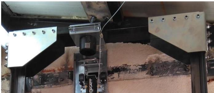
Das Rohr auf das Ende der Führungsschienen legen; beide Enden müssen auf eine Höhe zugeschnitten sein, damit das Rohr korrekt aufliegt. Den Komplex aus Rohr, Winkeln und Verbindungsbeschlägen für die Winkel jeweils mit den Führungsschienen verbinden.
